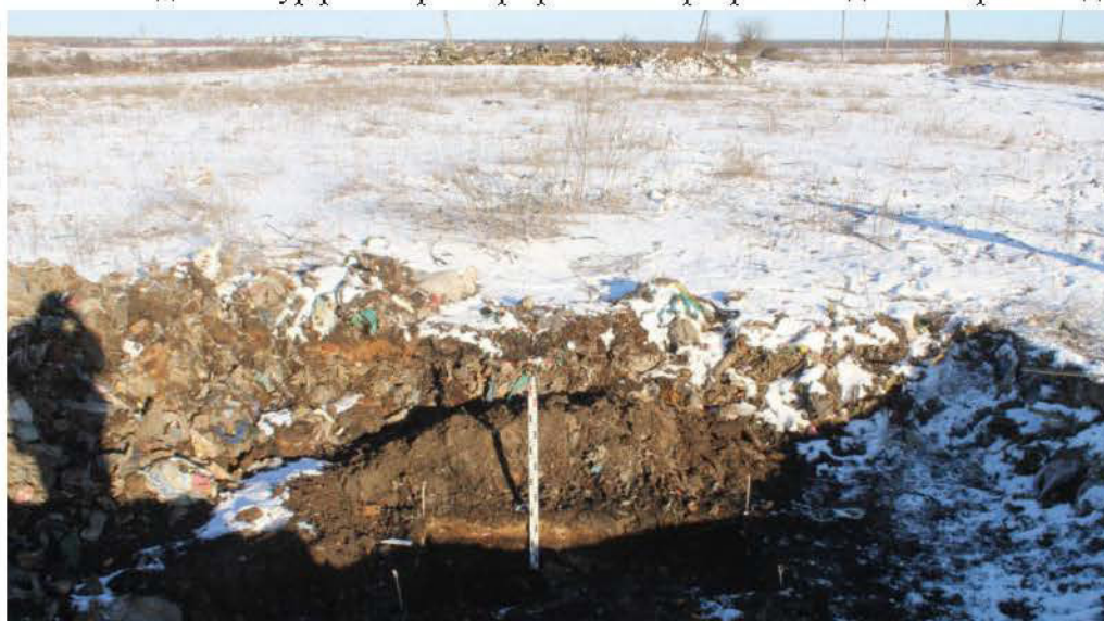
Рис. 56. Объект: «Рекультивация свалки, расположенной по адресу: Ростовская область, Неклиновский район, с. Покровское ( в южной части села), ул. О. Кошевого, полигон твердых бытовых отходов». Шурф 5. Вид до рекультивации. Вид с З.
