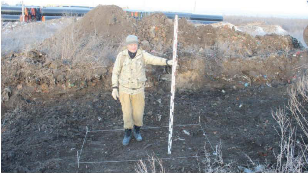
Рис. 33. Объект: «Рекультивация свалки, расположенной по адресу: Ростовская область, Неклиновский район, с. Покровское ( в южной части села), ул. О. Кошевого, полигон твердых бытовых отходов». Шурф 1. Вид до начала работ с Ю.
