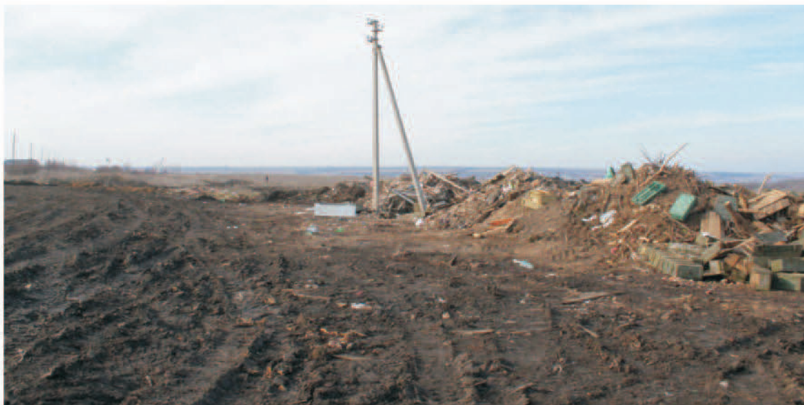
Рис. 6. Объект: «Рекультивация свалки, расположенной по адресу: Ростовская область, Неклиновский район, с. Покровское ( в южной части села), ул. О. Кошевого, полигон твердых бытовых отходов». Точка фотофиксации 1. Вид с В.
