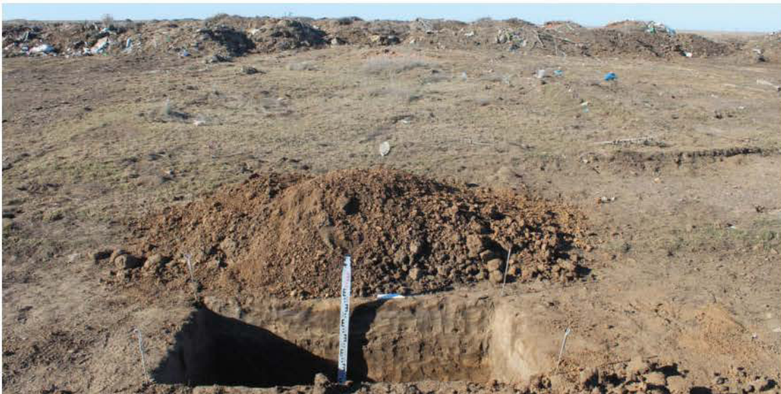
Рис. 82. Объект: «Рекультивация свалки, расположенной по адресу: Ростовская область, Неклиновский район, с. Покровское ( в южной части села), ул. О. Кошевого, полигон твердых бытовых отходов». Шурф 10. Вид до рекультивации. Вид с З.
