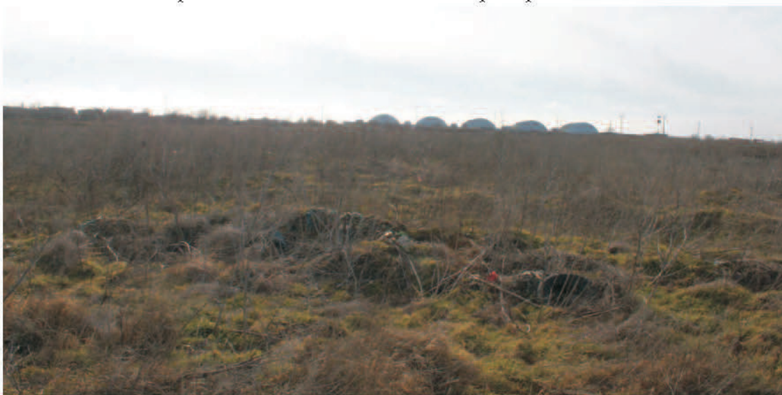
Рис. 26. Объект: «Рекультивация свалки, расположенной по адресу: Ростовская область, Неклиновский район, с. Покровское ( в южной части села), ул. О. Кошевого, полигон твердых бытовых отходов». Точка фотофиксации 6. Вид с ССВ.
