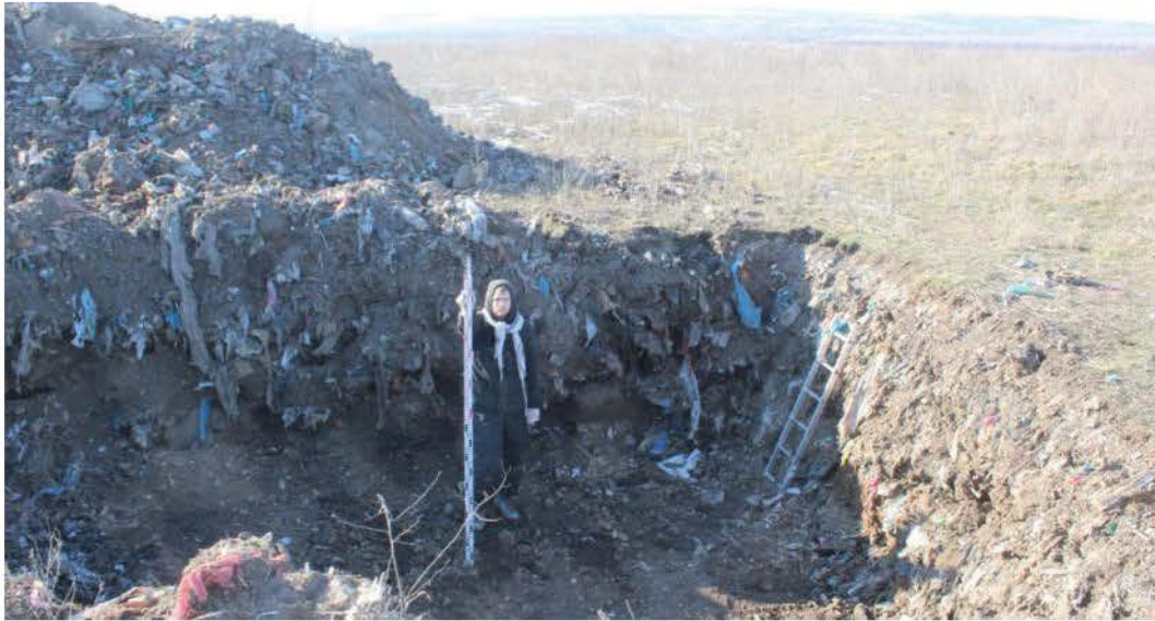
Рис. 42. Объект: «Рекультивация свалки, расположенной по адресу: Ростовская область, Неклиновский район, с. Покровское ( в южной части села), ул. О. Кошевого, полигон твердых бытовых отходов». Шурф 2. Вид после окончания работ с 3.
