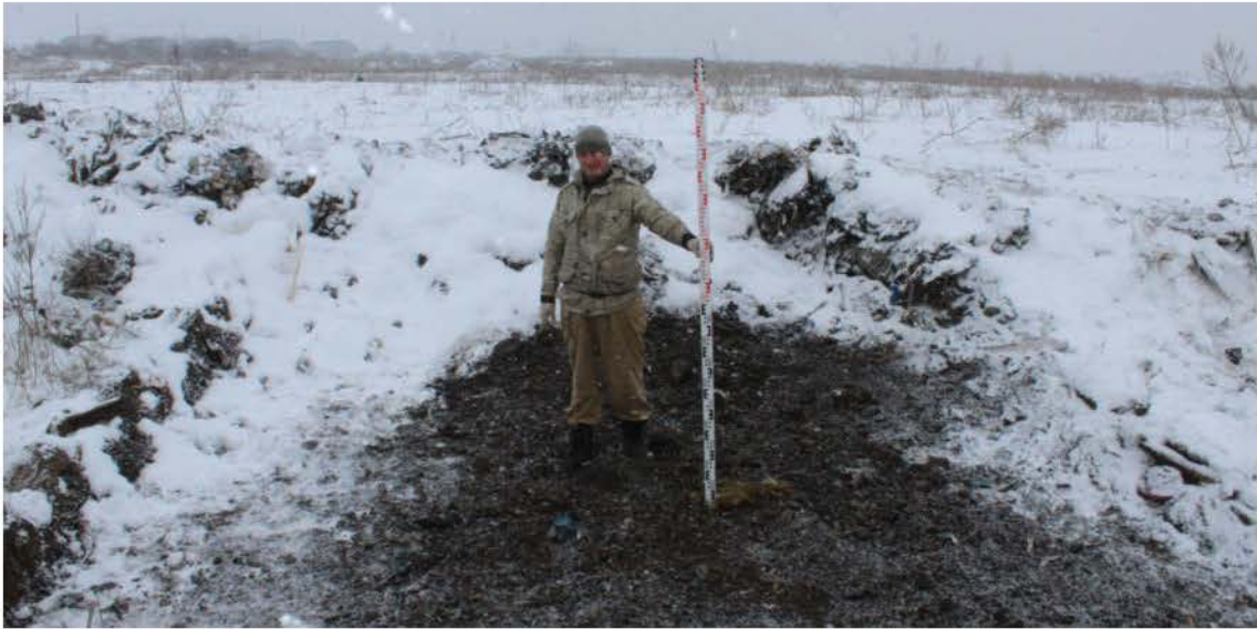
Рис. 78. Объект: «Рекультивация свалки, расположенной по адресу: Ростовская область, Неклиновский район, с. Покровское ( в южной части села), ул. О. Кошевого, полигон твердых бытовых отходов». Шурф 9. Вид после окончания работ с В.
