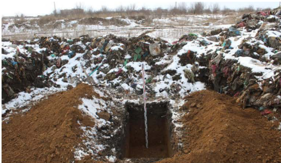
Рис. 51. Объект: «Рекультивация свалки, расположенной по адресу: Ростовская область, Неклиновский район, с. Покровское ( в южной части села), ул. О. Кошевого, полигон твердых бытовых отходов». Шурф 4. Вид до рекультивации. Вид с С.
