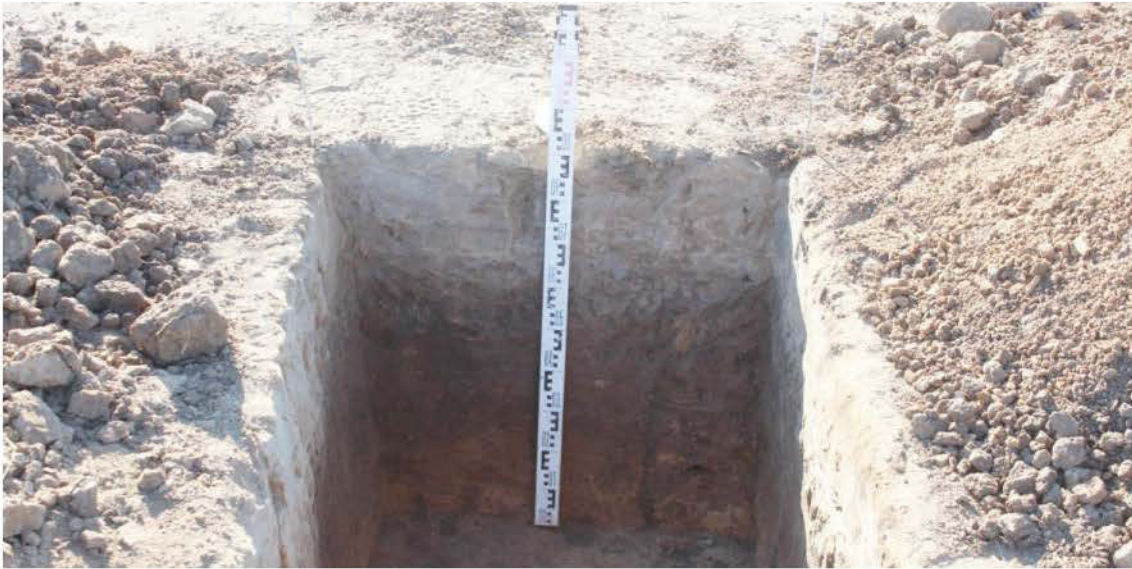
Рис. 81. Объект: «Рекультивация свалки, расположенной по адресу: Ростовская область, Неклиновский район, с. Покровское ( в южной части села), ул. О. Кошевого, полигон твердых бытовых отходов». Шурф 10. Стратиграфический разрез южного борта. Вид с С.
