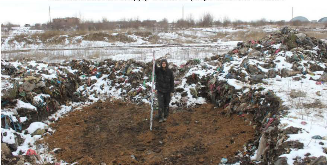
Рис. 52. Объект: «Рекультивация свалки, расположенной по адресу: Ростовская область, Неклиновский район, с. Покровское ( в южной части села), ул. О. Кошевого, полигон твердых бытовых отходов». Шурф 4. Вид после окончания работ с С.
