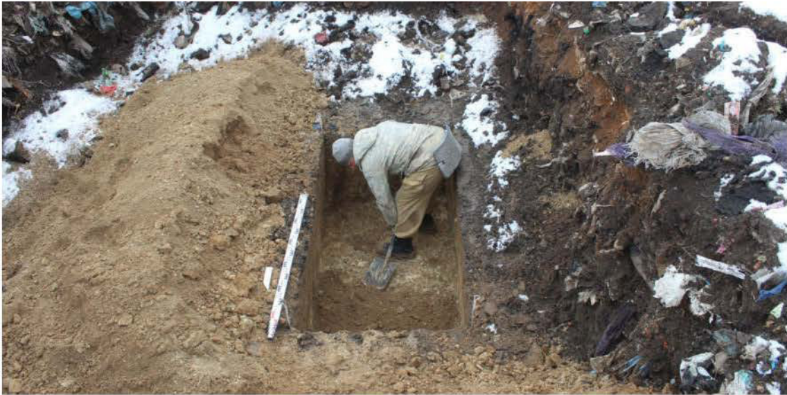
Рис. 69. Объект: «Рекультивация свалки, расположенной по адресу: Ростовская область, Неклиновский район, с. Покровское ( в южной части села), ул. О. Кошевого, полигон твердых бытовых отходов». Шурф 8. Рабочий момент. Вид с С.
