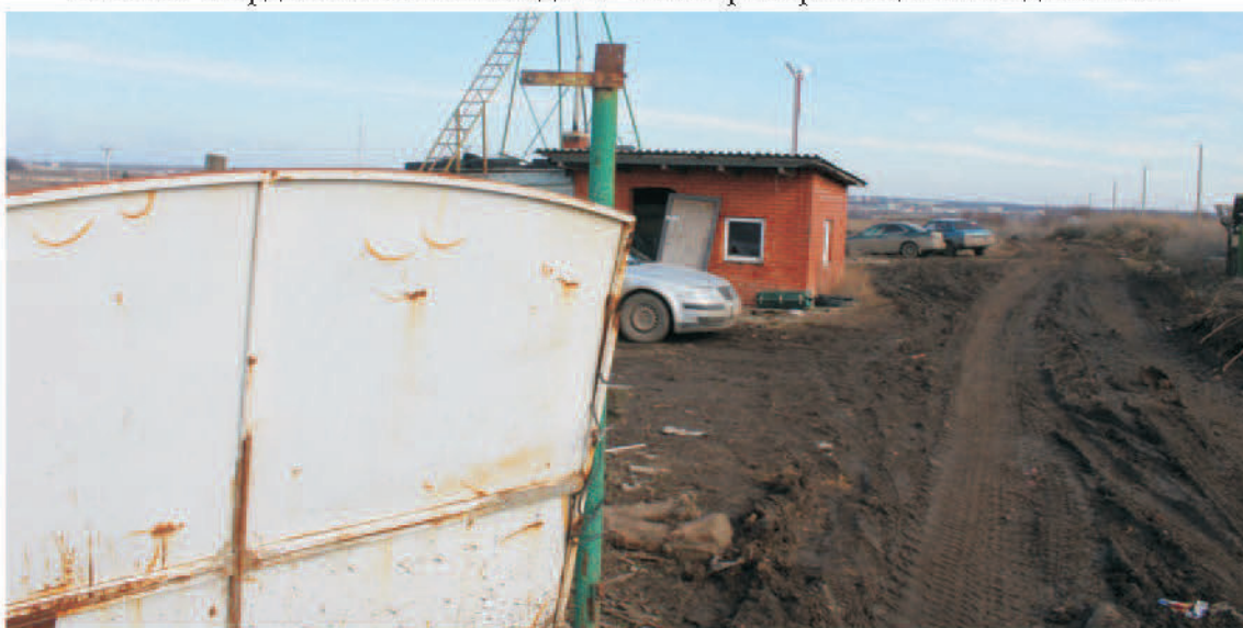
Рис. 20. Объект: «Рекультивация свалки, расположенной по адресу: Ростовская область, Неклиновский район, с. Покровское ( в южной части села), ул. О. Кошевого, полигон твердых бытовых отходов». Точка фотофиксации 4. Вид с ЮЗ.
