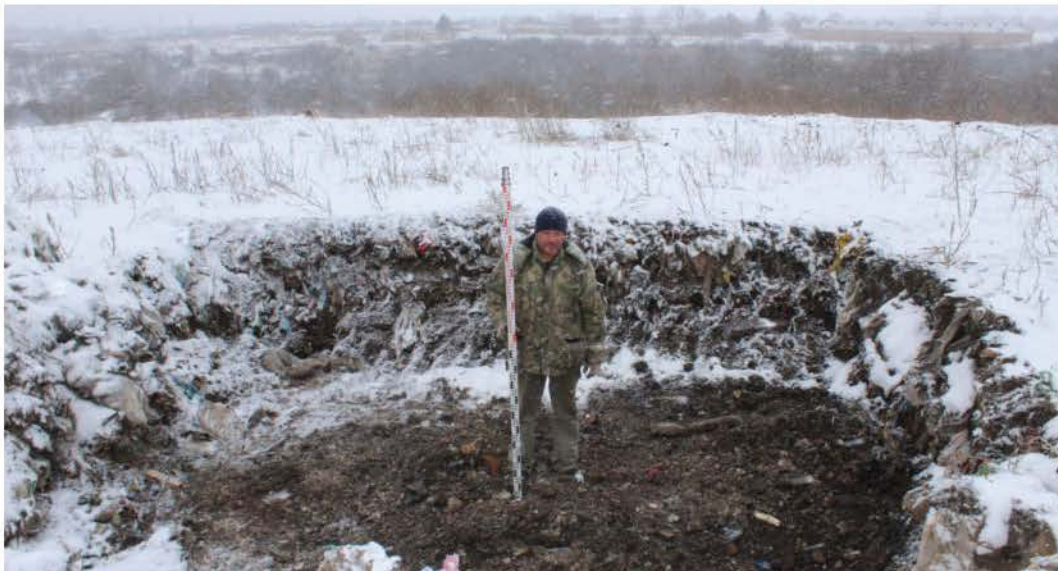
Рис. 67. Объект: «Рекультивация свалки, расположенной по адресу: Ростовская область, Неклиновский район, с. Покровское ( в южной части села), ул. О. Кошевого, полигон твердых бытовых отходов». Шурф 7. Вид после окончания работ с Ю.
