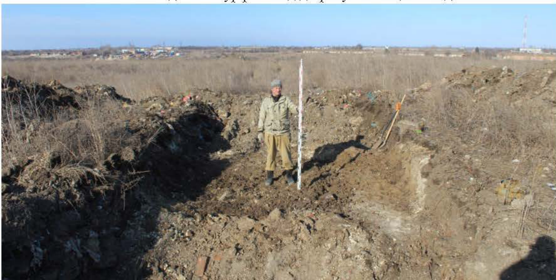
Рис. 62. Объект: «Рекультивация свалки, расположенной по адресу: Ростовская область, Неклиновский район, с. Покровское ( в южной части села), ул. О. Кошевого, полигон твердых бытовых отходов». Шурф 6. Вид после окончания работ с З.
