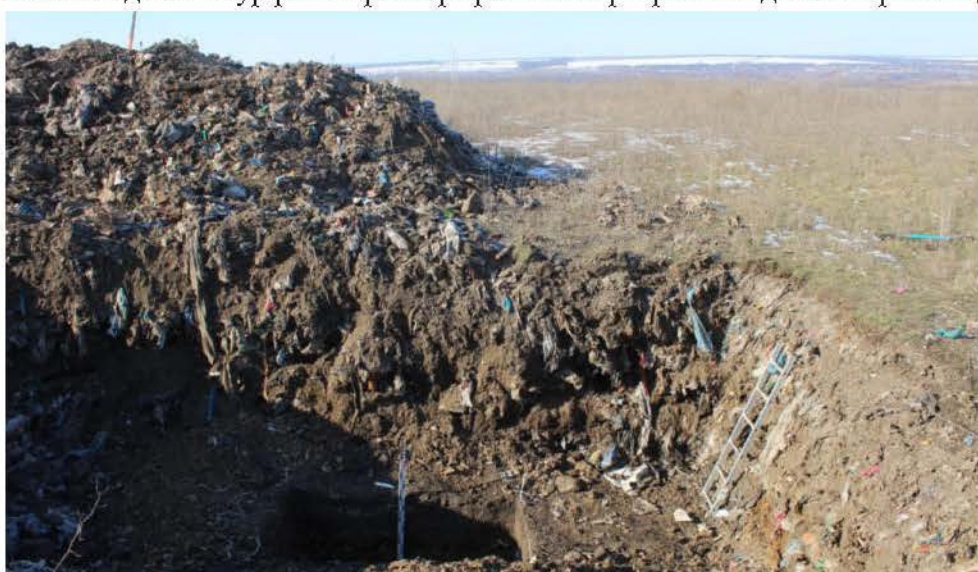
Рис. 41. Объект: «Рекультивация свалки, расположенной по адресу: Ростовская область, Неклиновский район, с. Покровское ( в южной части села), ул. О. Кошевого, полигон твердых бытовых отходов». Шурф 2. Вид до рекультивации. Вид с 3.
