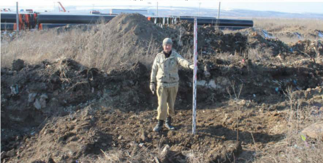
Рис. 37. Объект: «Рекультивация свалки, расположенной по адресу: Ростовская область, Неклиновский район, с. Покровское ( в южной части села), ул. О. Кошевого, полигон твердых бытовых отходов». Шурф 1. Вид после окончания работ с Ю.
