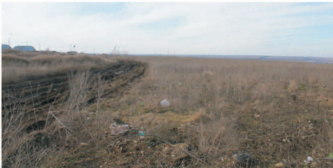
Рис. 9. Объект: «Рекультивация свалки, расположенной по адресу: Ростовская область, Неклиновский район, с. Покровское ( в южной части села), ул. О. Кошевого, полигон твердых бытовых отходов». Точка фотофиксации 2. Вид с В.
